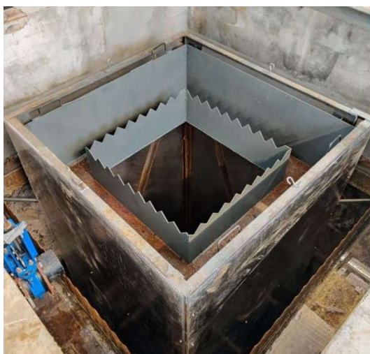
Рисунок 7 – Распределительный лоток во вторичном отстойнике после реконструкции
