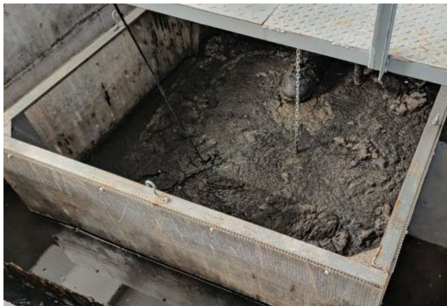
Рисунок 6 – Вторичный отстойник со вспухшим активным илом до реконструкции
