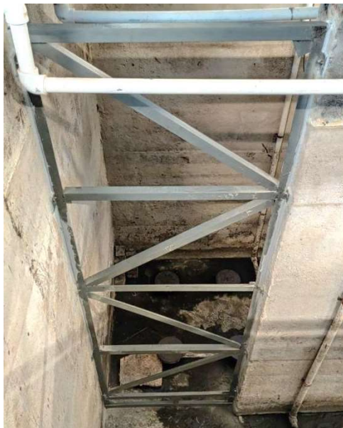
Рисунок 4 – Монтаж перегородки между секциями аэротенка
