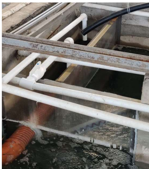
Рисунок 5 – Установленная перегородка после реконструкции
