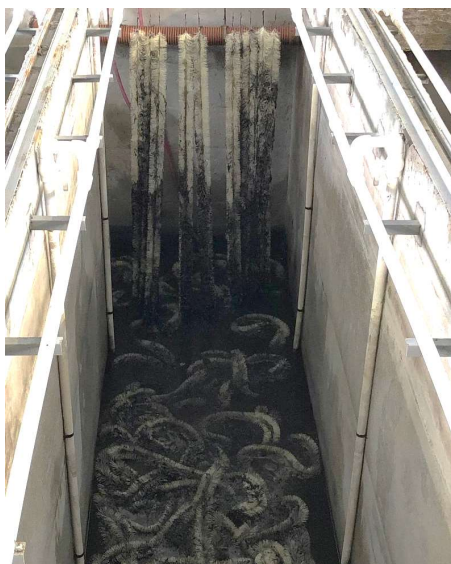
Рисунок 3 – Ершовая загрузка на дне аэротенка до реконструкции
