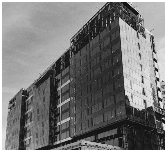
Рис. 1. Состояние строящегося объекта на октябрь 2020 года
