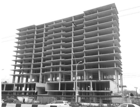
Рис. 2. Возведенный годами ранее монолитный железобетонный каркас
