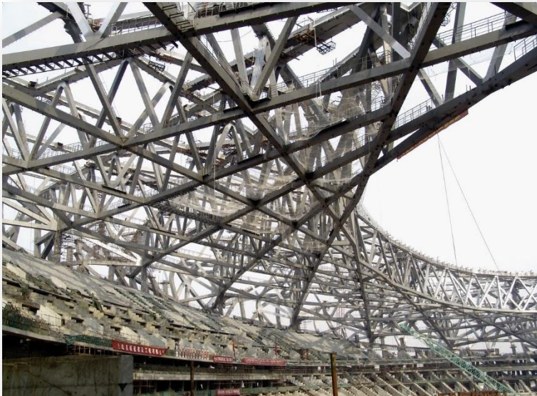
Рис. 6 — Основной металлический каркас стадиона «Птичье гнездо»
