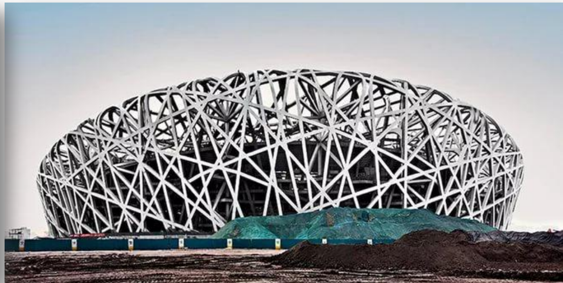
Рис. 6 — Основной металлический каркас стадиона «Птичье гнездо»
